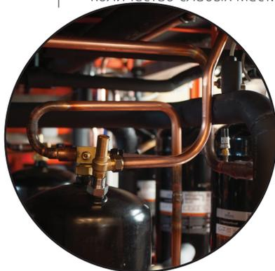
**Применение ЧПУ-гнутых трубопроводов** для встроенных холодильных машин позволяет значительно сократить количество сварных соединений и, как следствие, количество слабых мест.
